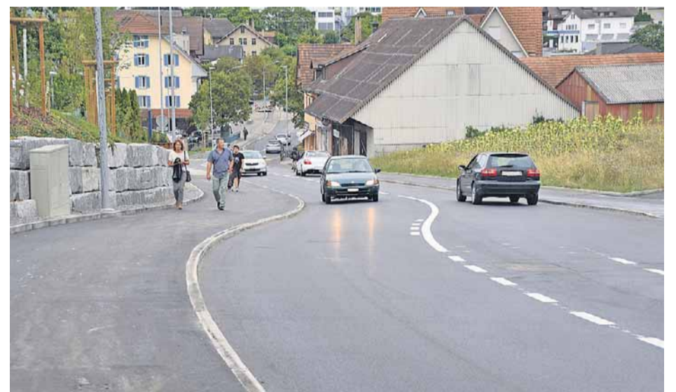
Sanierter Abschnitt der Bahnhofstrasse im Bereich der Schulanlage Risi.
